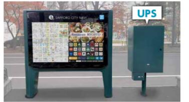
災害によって通常の電力供給が受けられなくなった場合でも、UPS(無停電電源装置)を装備することで自動的に電力システムを切り替え、表示システムを維持します。また、積雪や寒冷地特有で想定される不具合に対しても電源を確保することでシステムの安定稼働に貢献できます。
