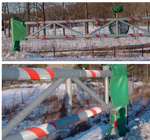
再帰反射シート(シルバー)に透明赤色シルクスクリーン印刷
