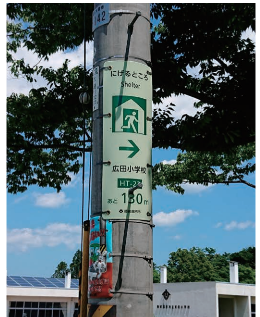
裏面:支柱・取付金具留め
